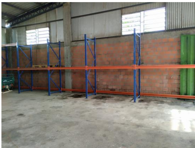
Rack para almacenamiento de producto enfardado
