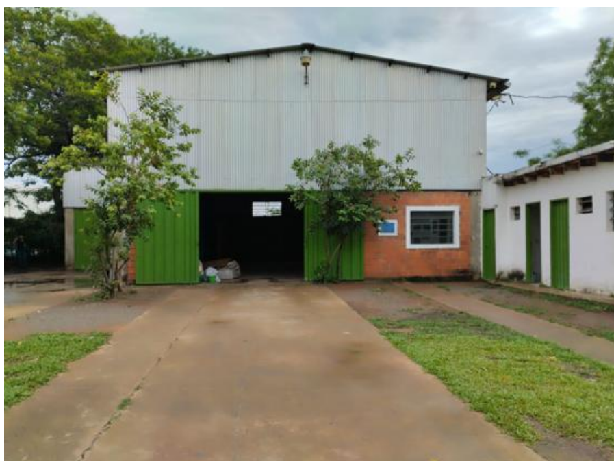
Vista general de la planta de reciclado
